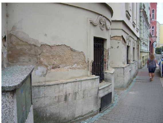
Postupující opadávání zdiva, narušené římsy u objektu v ul. Komenského
