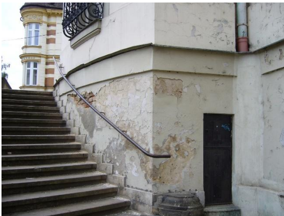
Postupující opadávání zdiva, narušené římsy u objektu v ul. Komenského
